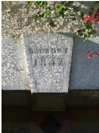
L’utilisation de la boucharde s’est répandue en Béarn au XVIII e siècle, cet outil de sculpteur produit une surface guillochée. Le nom du propriétaire est ici inscrit : c’est le cas à Rébénacq pour trois maisons édifiées par des hongreurs.
