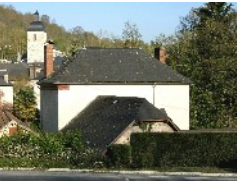
Route de Pau : cette maison d’habitation a été reconstruite en 1887, en extension d’une maison ancienne d’orientation différente.
