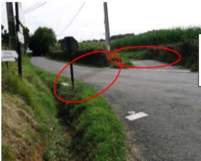
Eaux pluviales captées et renvoyées dans le fossé opposé par une buse en 400 pour déversement sur l'autre versant.
