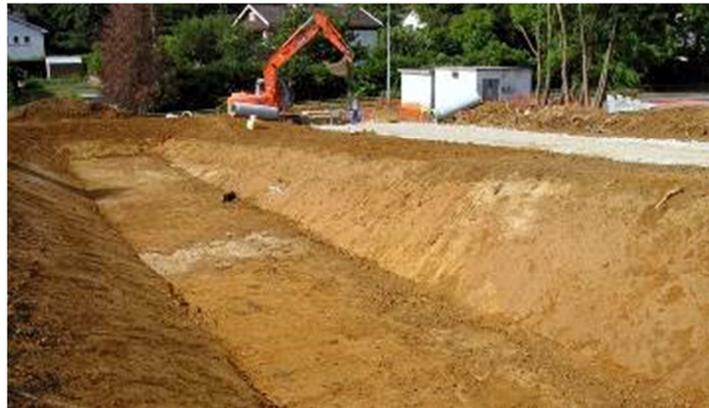
Figure 3 : Exemple de mise en place d'un bassin de rétention des eaux pluviales
