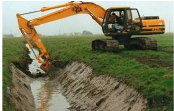
Figure 2 : Exemples de curage et reprofilage de fossé
